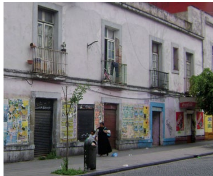
Vivienda precaria, calle República de Perú, Centro Histórico de la Ciudad de México, delegación Cuauhtémoc, DF.
