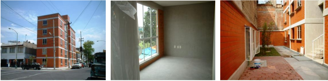
Predio Norte 25 No. 99, ejemplo de viviendas con acabados aparente en muros y losas.
