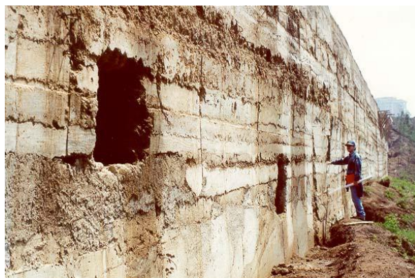
Fig 13 Terraplén de suelo-cemento
